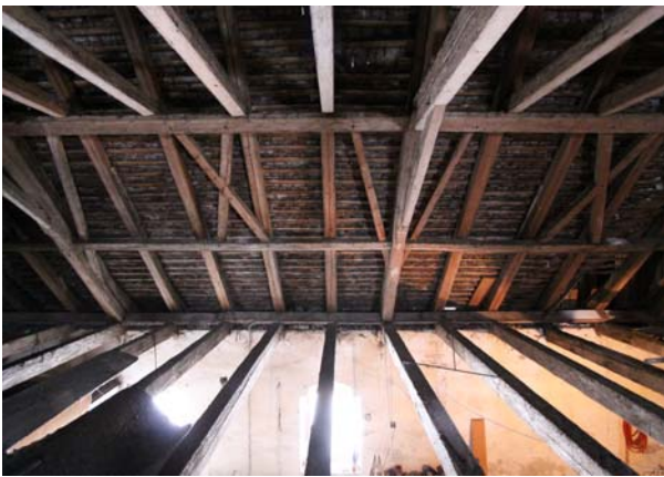
“Alte Schäferei”, roof framework
