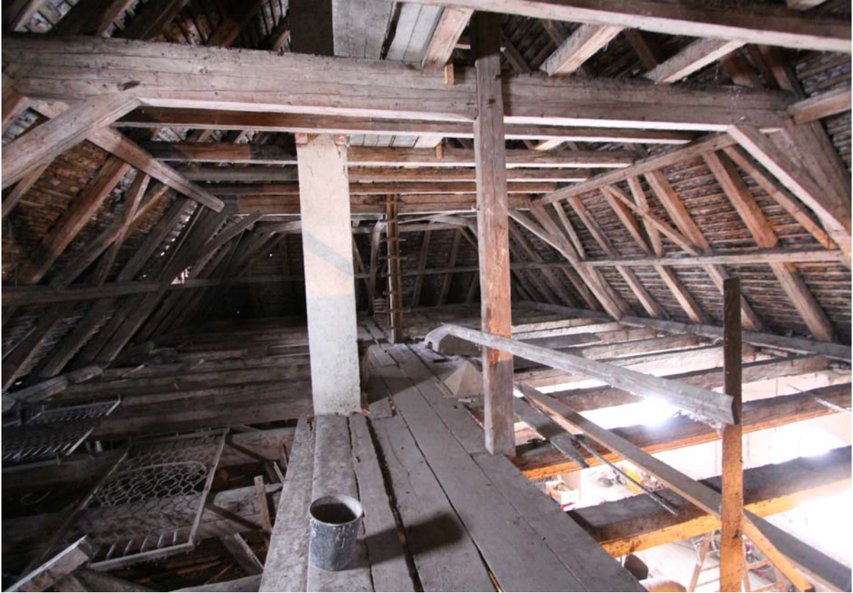
“Alte Schäferei”, roof framework
