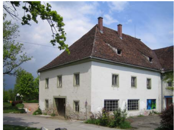
"Alte Schäflerei", Benediktbeuern Monastery
